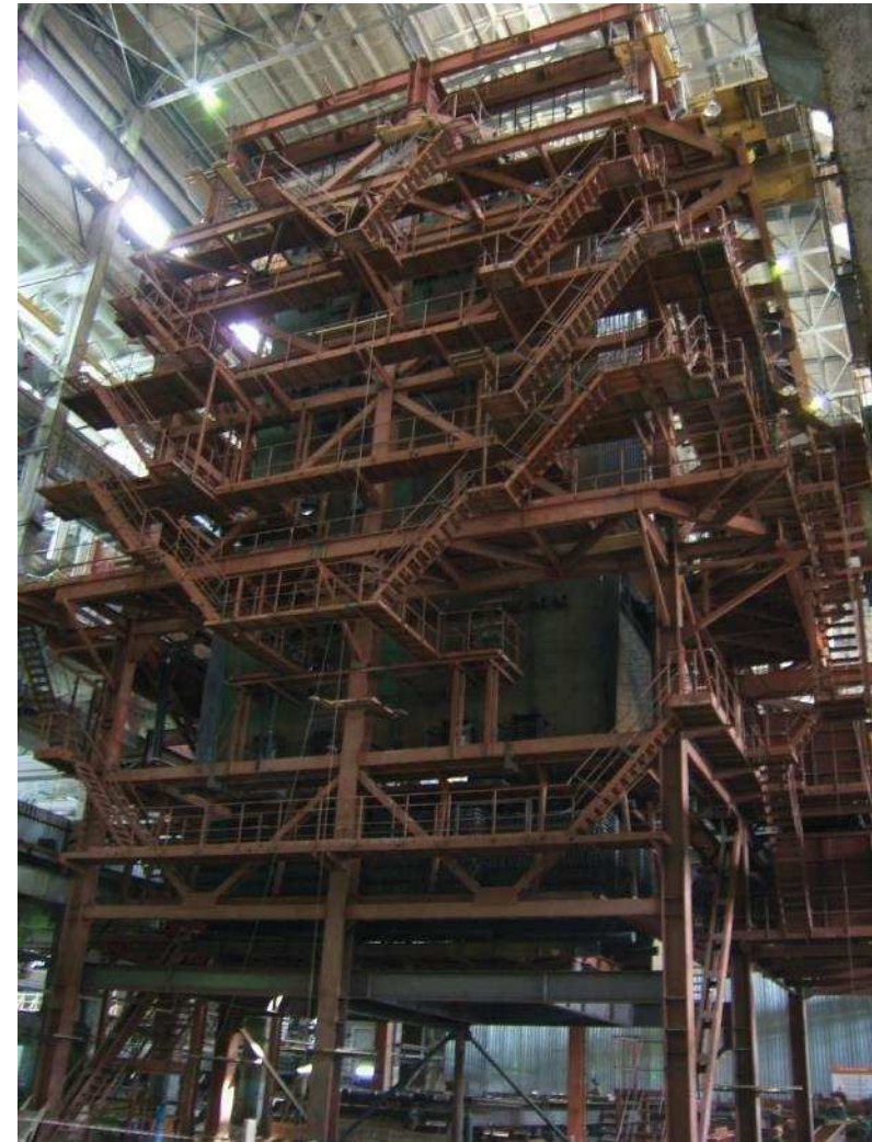
Котел E-500 в стадии монтажа
