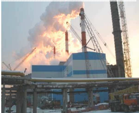
Монтаж дымовой трубы (декабрь 2009)
